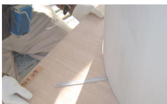
平滑性の確保、特に角部や曲面は原寸の定規を作成し、入念に確認した。
