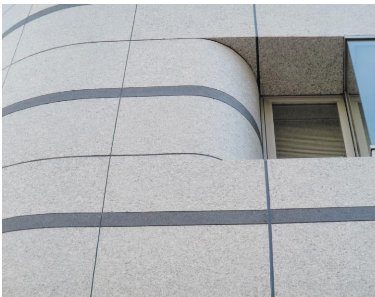
北西面 エントランス 上部 拡大
