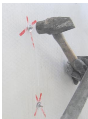
アンカーピン打ち込み。
