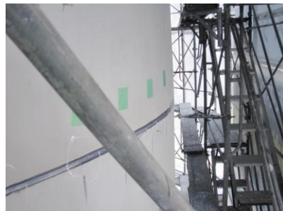
タイル面の段差を平滑にするため、カチオンフィラーを丁寧に2回塗りました。
