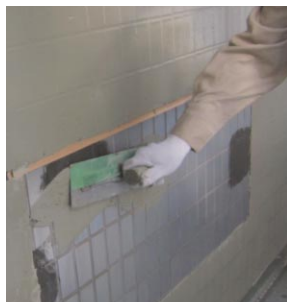
タイル面の段差を平滑にするため、カチオンフィラーを丁寧に2回塗りました。
